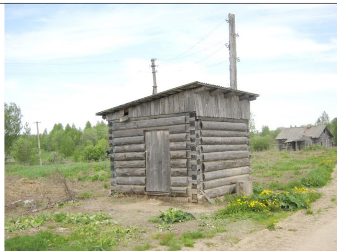
Рисунок 6.4.2 – Павильон скважины в д. Конышево
