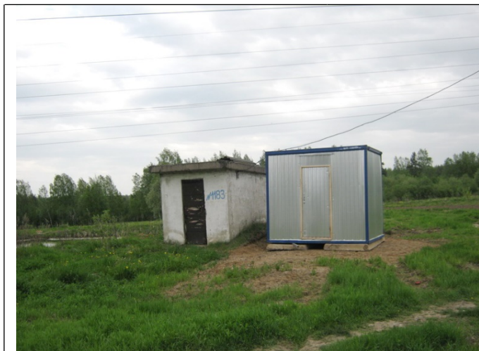
Рисунок 6.4.14 – Павильон скважины №1183 в м-не Черемушки, п. Антропово
