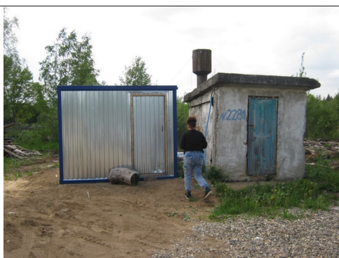
Рисунок 6.4.11 – ВНБ и павильон скважины №2281 в п. Антропово, ул. Труда
