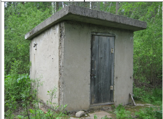
Рисунок 6.4.3 – Павильон скважины в д. Могучево
