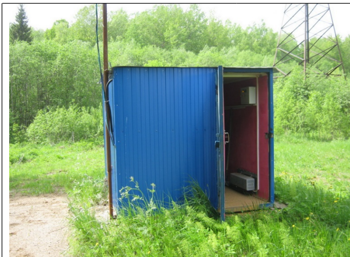
Рисунок 6.4.8 – Павильон скважины №1154 по ул. Лебедева, п. Антропово
