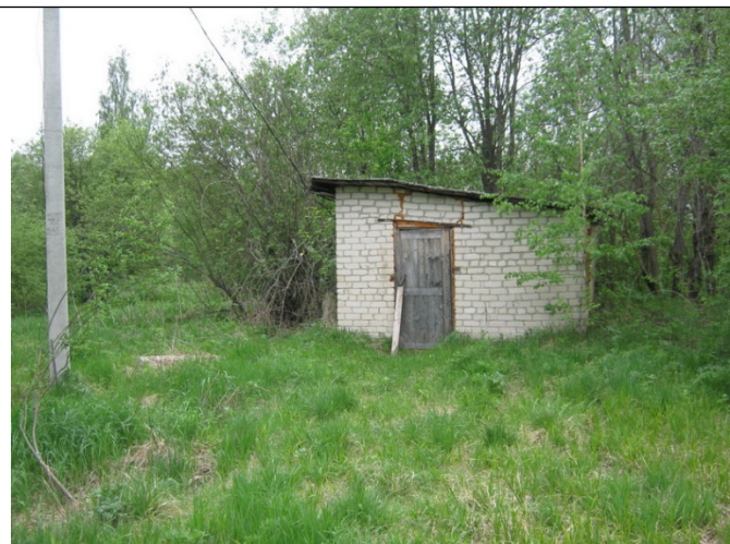
Рисунок 6.4.15 – Павильон скважины по ул. Совхозная, с. Палкино
