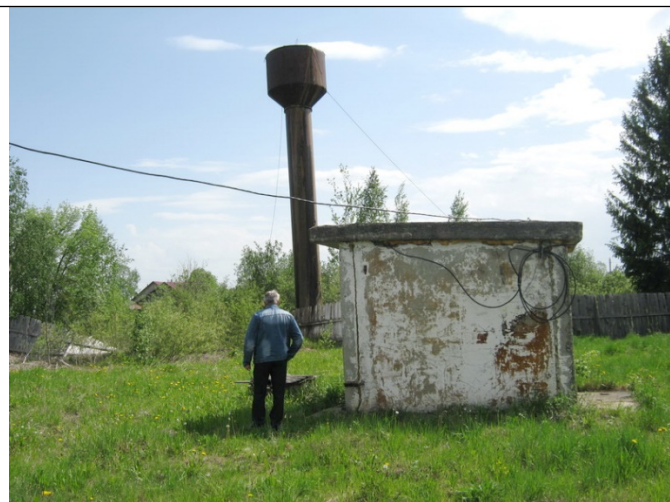
Рисунок 6.4.9 – ВНБ и павильон скважины №3319 в п. Антропово, ул. Урицкого
