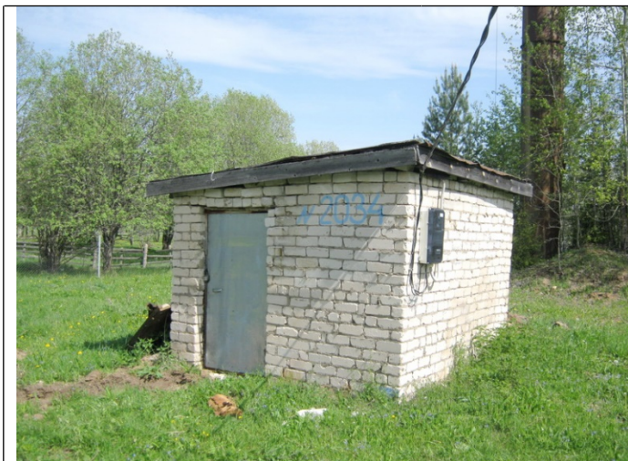
Рисунок 6.4.1 – Павильон скважины в д. Просек
