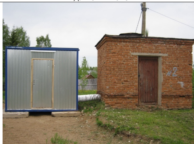
Рисунок 6.4.4 – Станция водоочистки и павильон скважины №2 по ул. Энергетиков, п. Антропово
