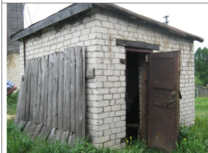
Рисунок 6.4.16 – Павильон скважины №3296 в м-не ПМК, с. Палкино
